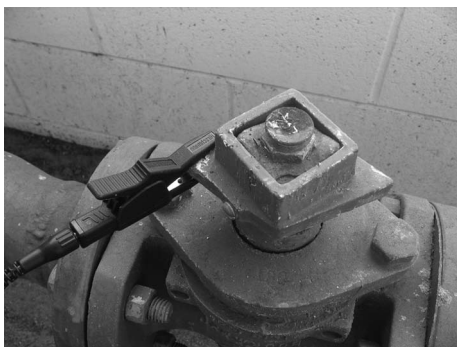
Рис. 9: Пример подсоединения к газовой магистрали
