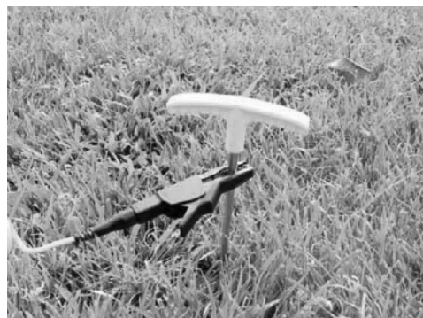
Рис. 8: Подсоединение провода к заземляющему штырю
